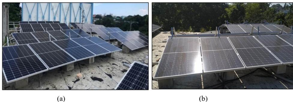
**Figura 1.** Arreglos compuestos por módulos solares Amerisolar AS-6M30-HC-335W, (a) orientación fija hacia el sur con ángulos de inclinación variable, (b) inclinación de 10 grados y orientación este-oeste
