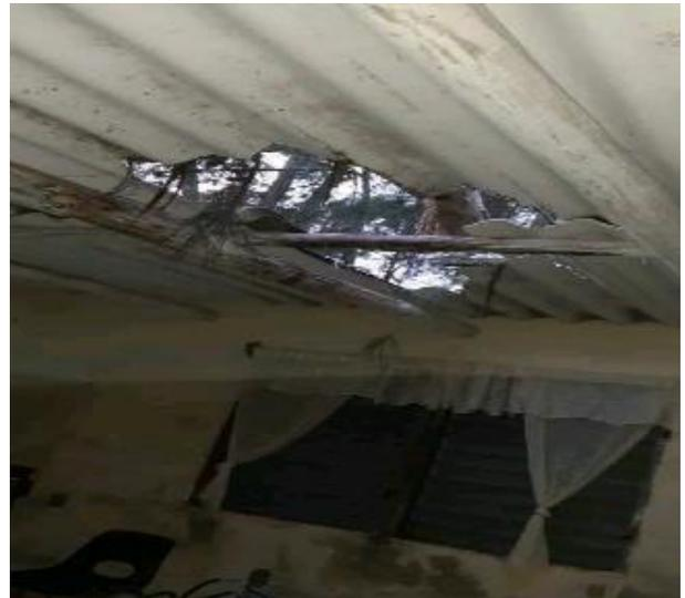
**Figura 20.** vivienda con afectación parcial de techo. Cortesía de Alejandro Lóriga
