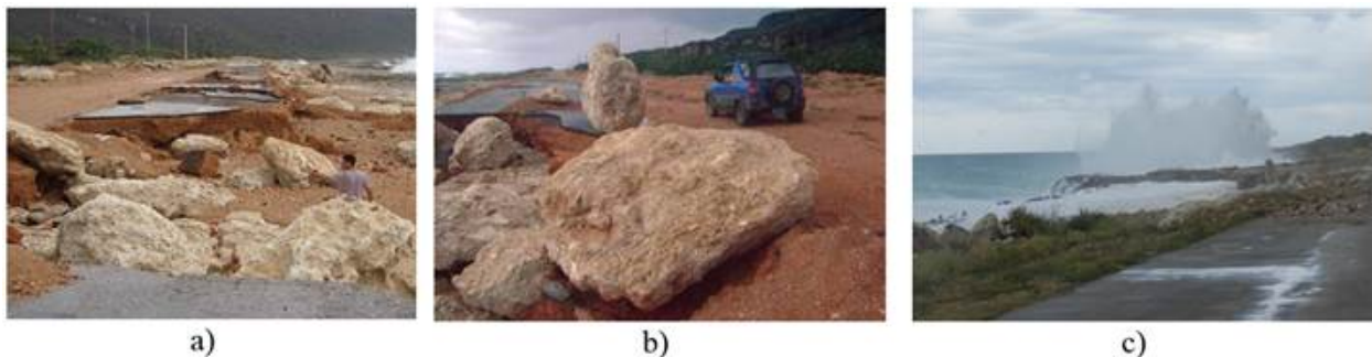
Figura 7. Sector costero del Bate-Bate (localizado en la costa sur de Guantánamo) que muestra abundantes huracanolitos sobre el primer nivel de la terraza marina (a) y (b), producto de las fuertes inundaciones costeras (c), provocadas por los embates del huracán Sandy, que interrumpieron el tránsito vehicular por este tramo de la carretera Guantánamo - Baracoa.
