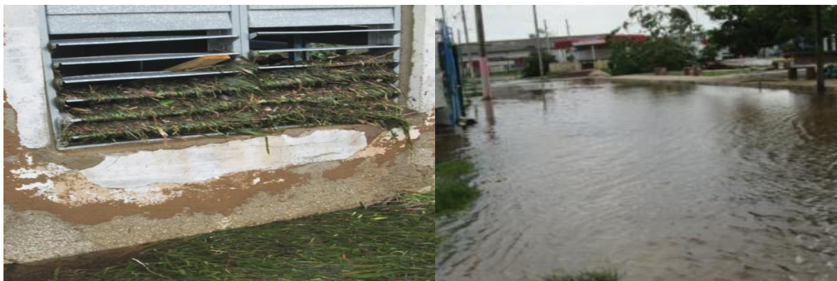
Figura 9. Evidencias de la penetración del mar en el poblado de Júcaro con el huracán Irma. Fuente: Informe de Evaluación del Impacto Ambiental del Desastre provocado por Irma (Huracán de Gran Intensidad) en la provincia Ciego de Ávila. Delegación Territorial del Ministerio de Ciencia, Tecnología y Medio Ambiente (Inédito)
