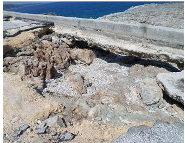
**Figura 31.** Vía de acceso destruida por la fuerza del oleaje (Puerto Escondido, Santa Cruz del Norte)
