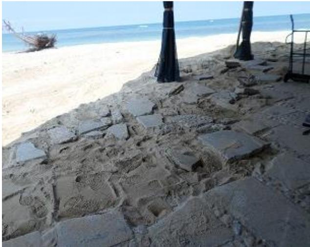
**Figura 28.** El piso levantado por la acción del oleaje (Hotel Memories Jibacoa, Santa Cruz del Norte)
