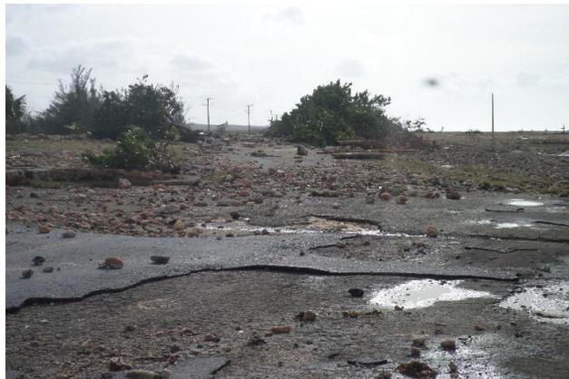
**Figura 16.** Erosión del asfalto (El Cayuelo, Boca de Jaruco, Mayabeque)
