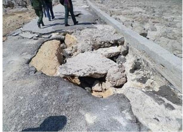
**Figura 33.** Vía de acceso destruida por la fuerza del oleaje (Puerto Escondido, Santa Cruz del Norte)
